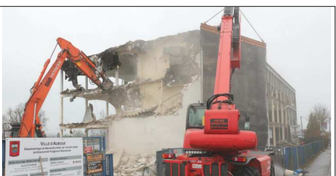
Désamiantage - Démolition ancien LEP 130 865 €
